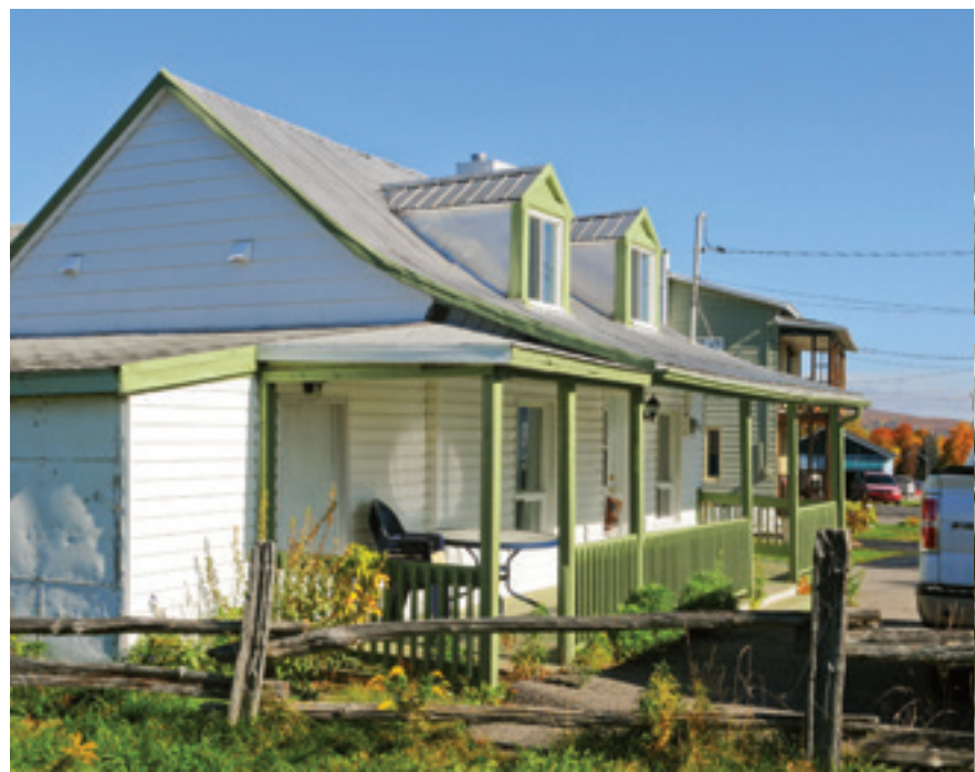
∨ Orientée au sud, l'une des maisons anciennes du secteur. Photographie Ville de Québec.
